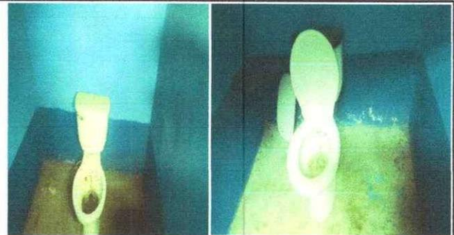
Foto 4: LOS SANITARIOS COLAPSADOS, NECESITAN REPARLOS
